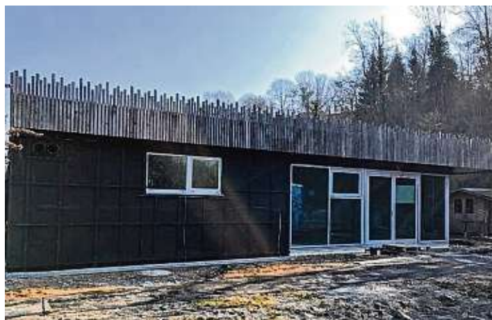
Der Inbetriebnahme der dritten Gruppe zum 1. April steht von baulicher Seite nichts im Wege. Allerdings ist durch die aktuelle Corona-Situation die pünktliche Inbetriebnahme durch das Kindergarten-Team nicht möglich. Bild: Stadt Engen
